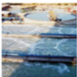
Effluent Treatment Plant (ETP)
